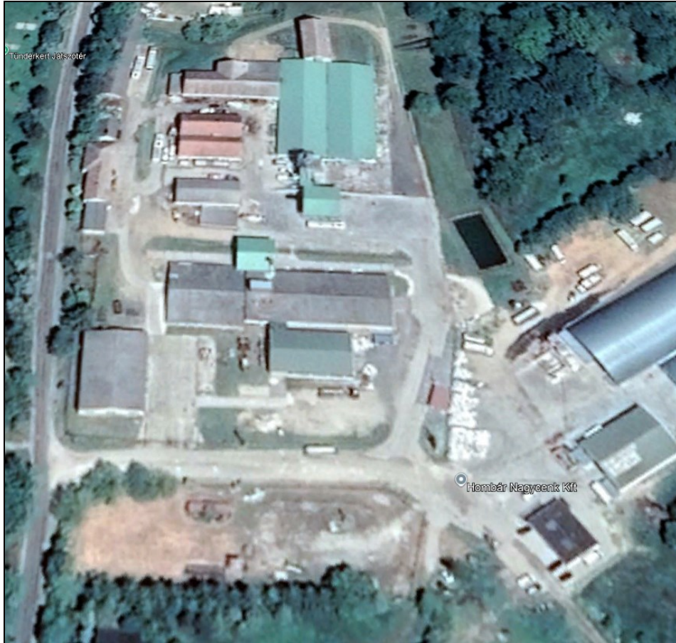
Az érintett telektömb déli oldalán lévő, meglévő gazdasági terület közötti kapcsolatát biztosító telekbejáró. /Forrás: Google Earth Pro/
